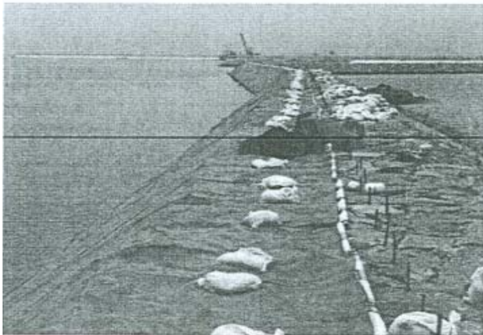
<그림 2> 방사 시트의 시공 예
